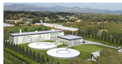
Traitement de l'eau
